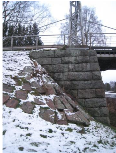
kuva 15. Keilan kiviverhouksessa on siirtymää.
