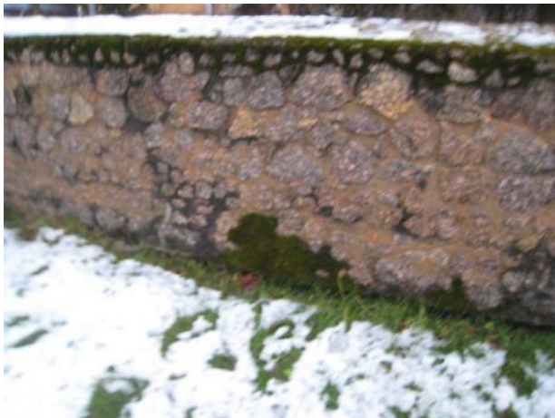
kuva 4. Kiviverhotussa betonikaiteessa on rapautumista
