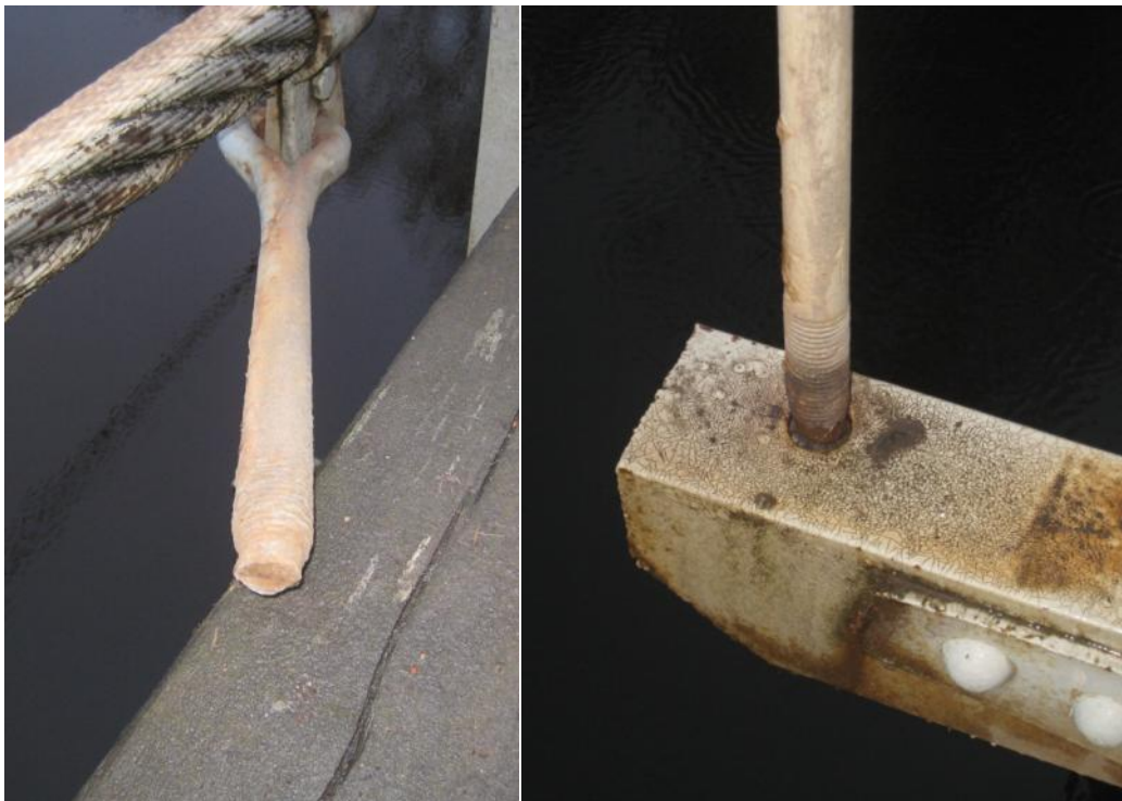
kuvat 9 ja 10: Riipputangot ovat kuluneet erittäin pahasti ja yksi tanko on jo katkennut
