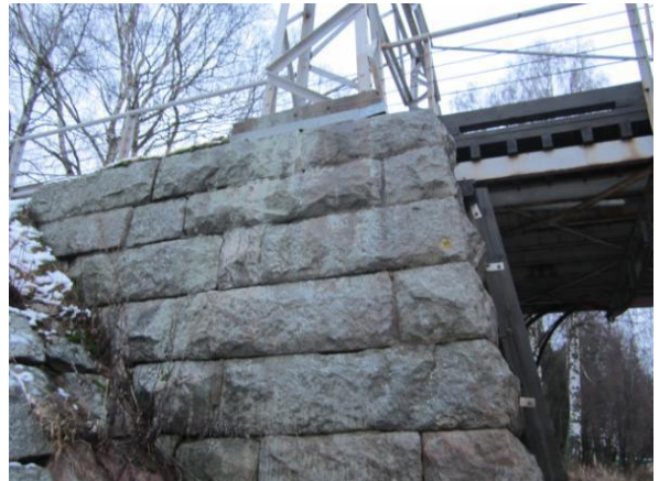
kuva 1. Sillassa on kiviset massiiviset maatuet.
