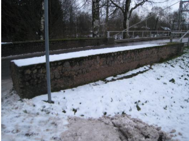
kuva 3. Sillan päädyissä on massiiviset vastapainot, joihin riippuköydet on ankkuroitu.
