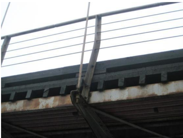
kuva 14. Kaiteissa on taipumia.
