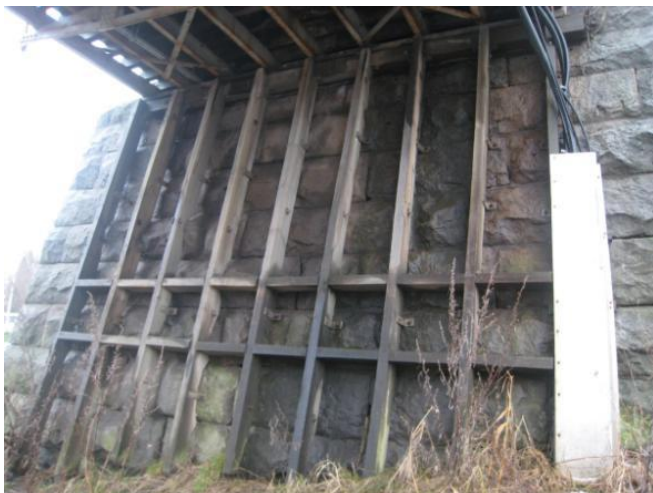
kuva 2. Maatukeen on kiinnitetty puuristikko, joka tukee laakeritason levennystä
